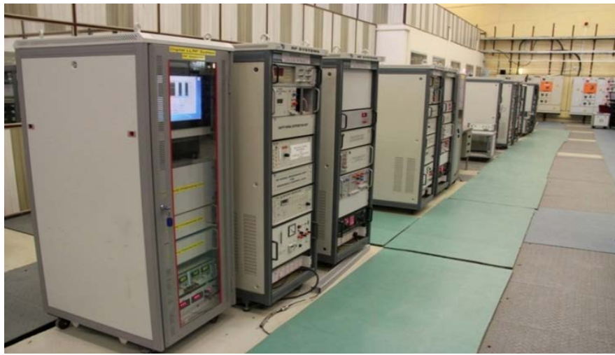
चित्र-21 : इण्डस -2 में आर.एफ. केन्द्रों के साथ स्थापित डिजिटल एल.एल.आर.एफ. प्रणाली।
